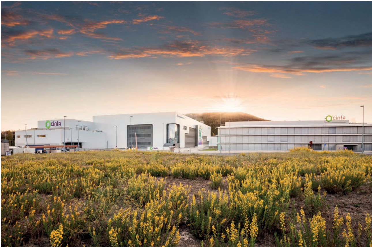
Imagen del exterior de las instalaciones situadas en Ollki.
